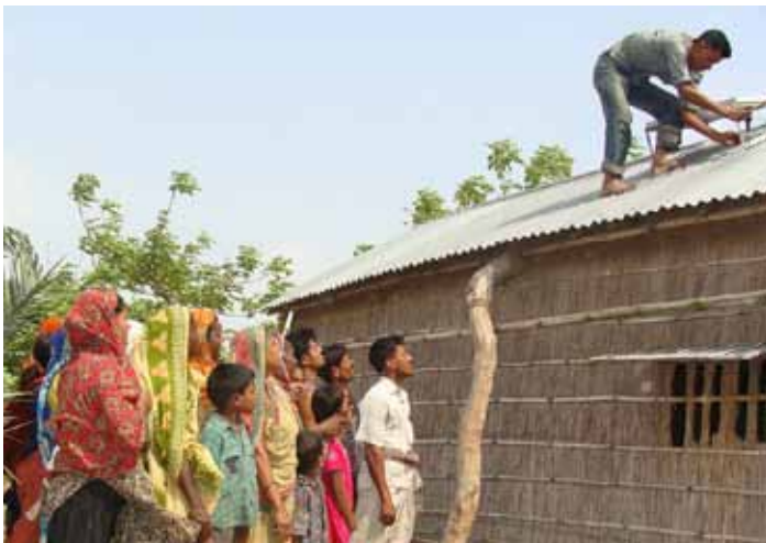
Ein spannender Moment: die Sonnenkollektoren werden installiert
